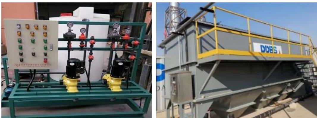
图 3.6-32 混凝沉淀池及配套设施
