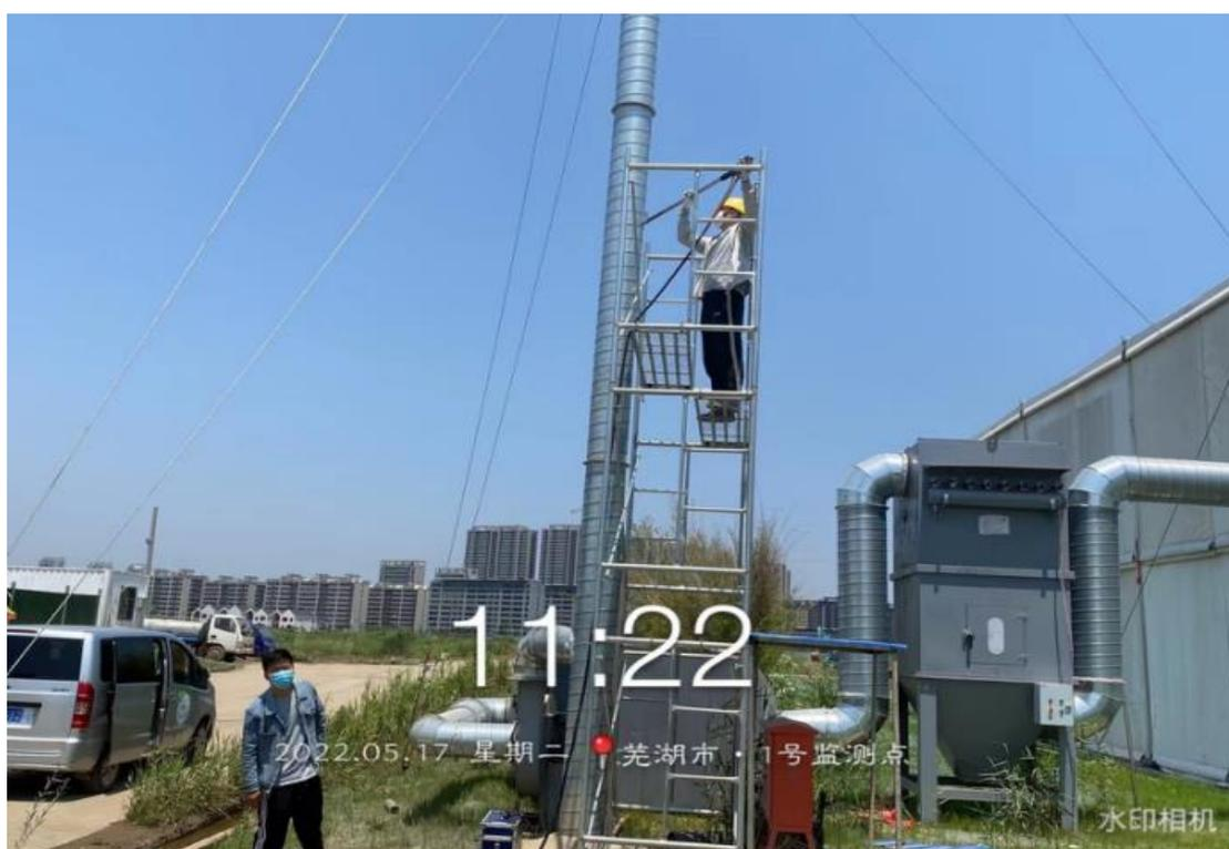
图 3.7-9 有组织废气监测采样
