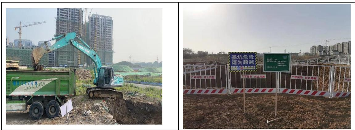
图 3.6-20 基坑土方开挖
