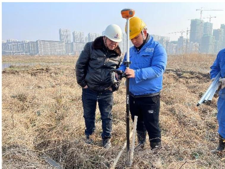
图 3.6-18 RTK 定点放线
