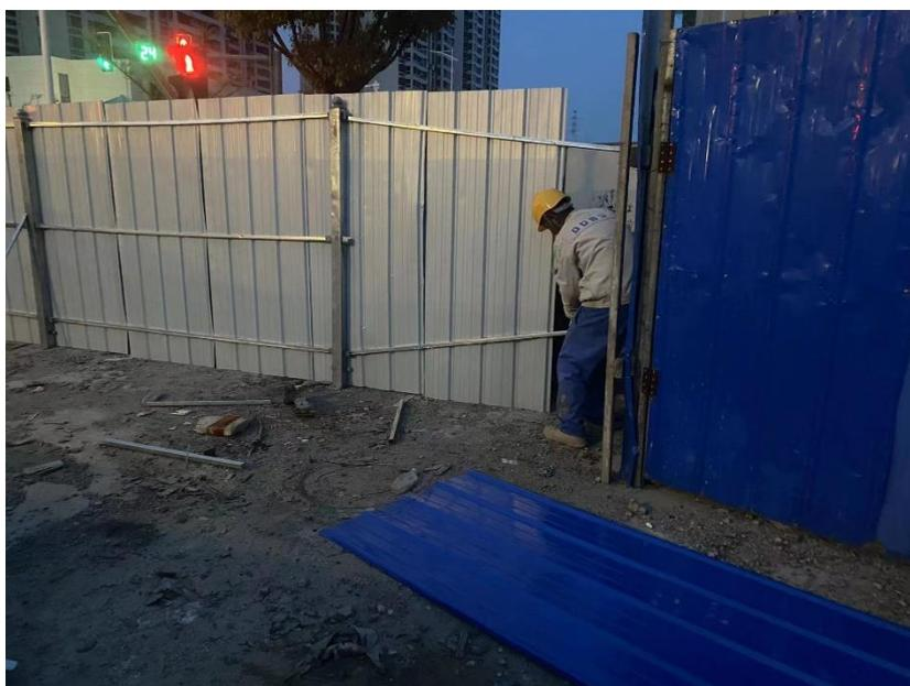
图 3.6-5 对破损围墙进行修补和加固
