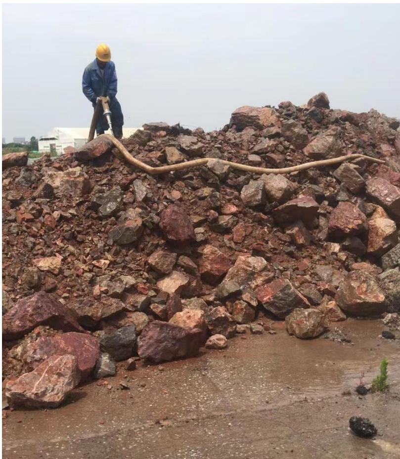
图 3.6-28 建筑石块高压冲洗
