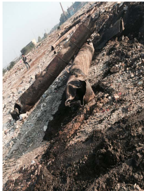
废管材、电缆挖掘回收
