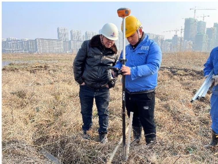
图 3.6-21 RTK 定点放线
