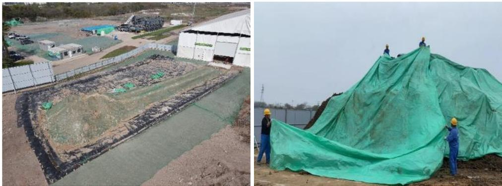
图 3.6-31 修复后的土壤转移至养护区覆盖
