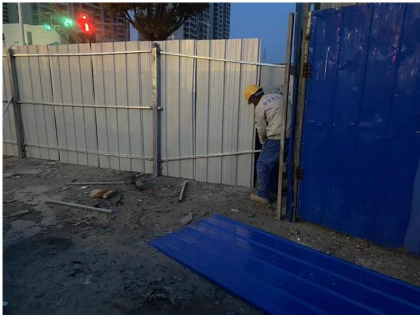
图 3.6-8 对破损围墙进行修补和加固
