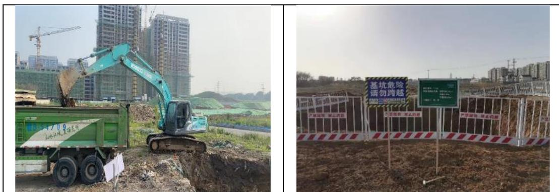
图 3.6-24 基坑土方开挖
