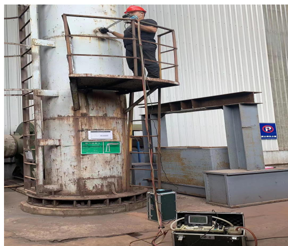
料场 8#转运站废气处理设施出口 (Qf2) 监测
