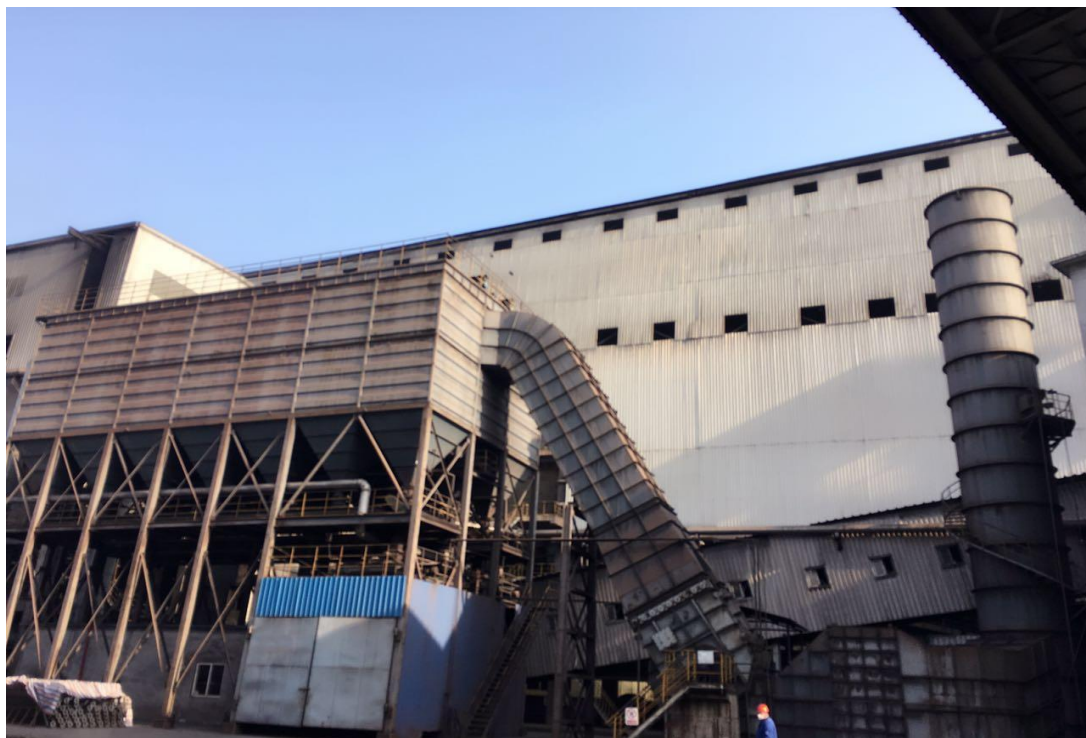
炼铁 2#高炉矿槽除尘器
