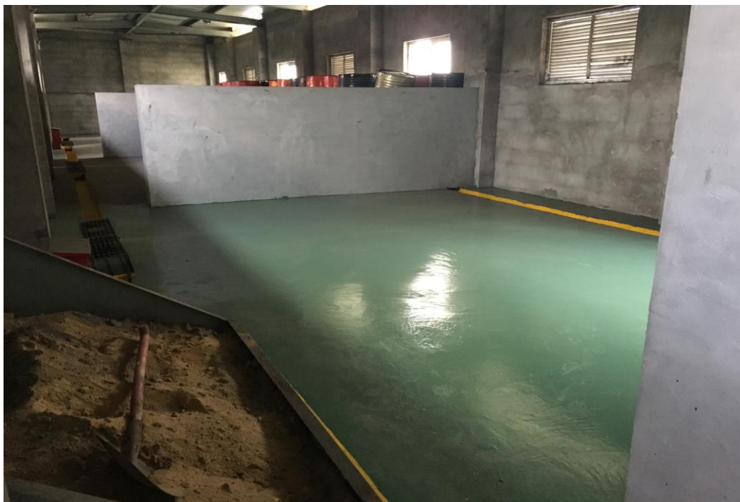
公司危废暂存库
