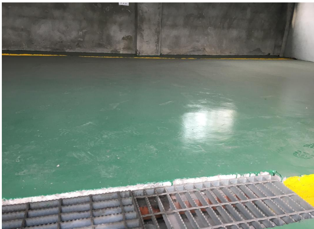
公司危废暂存库
