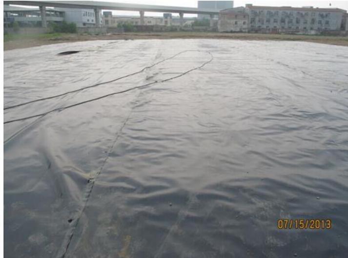
图 6-11 场地铺设 HDPE 防渗膜示意图
