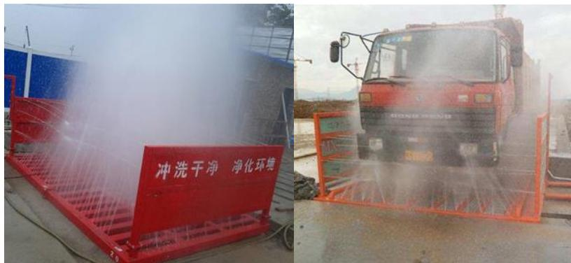
图 6-1 车辆清洗示意图
