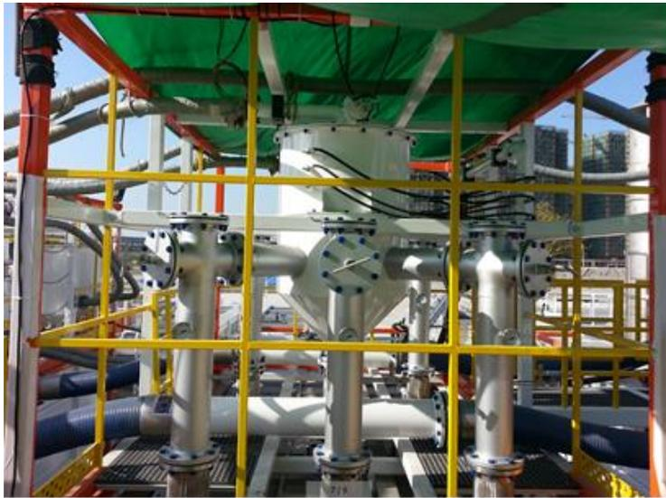
图 2-4 喷淋冷凝系统局部图
