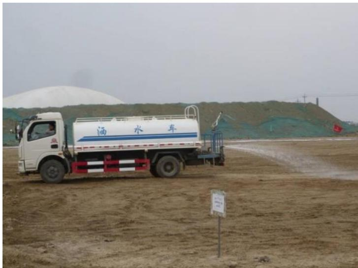
图 11-13 洒水车现场降尘作业
