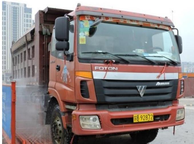
图 11-12 出厂汽车清洗槽
