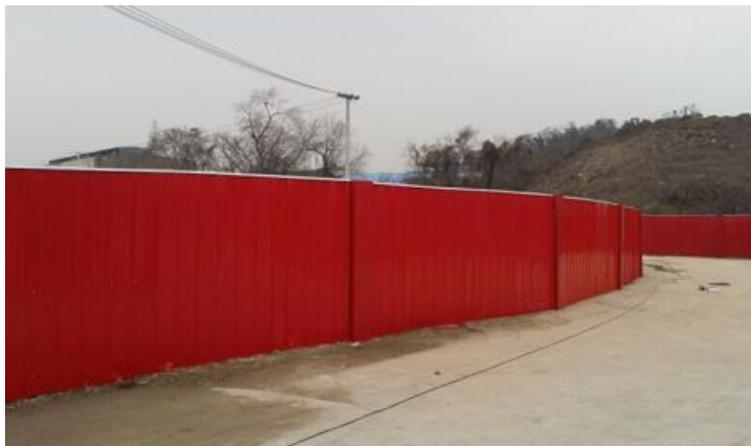
图 3-1 施工区围挡示意图
