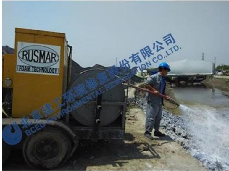
图 6-7 气味抑制剂喷洒现场
