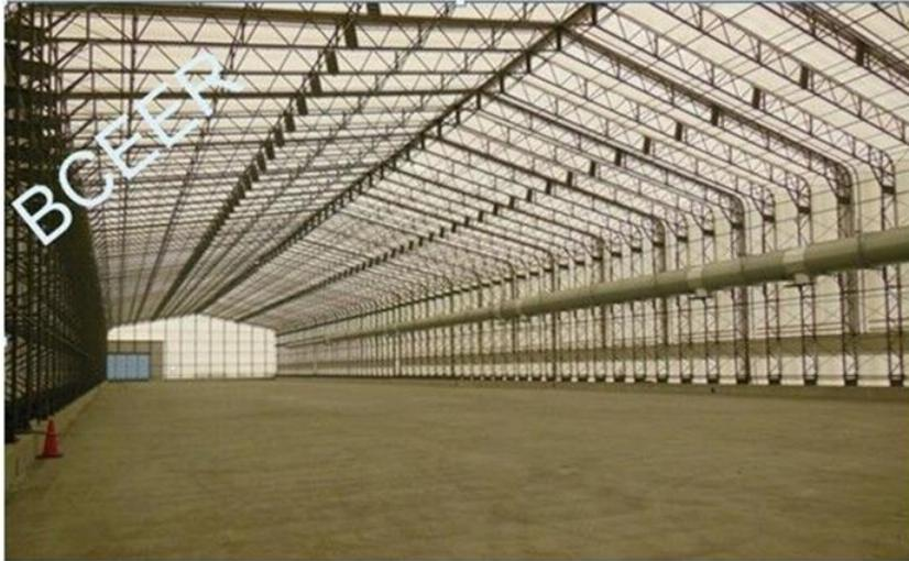
图 6-3 钢结构骨架式车间
