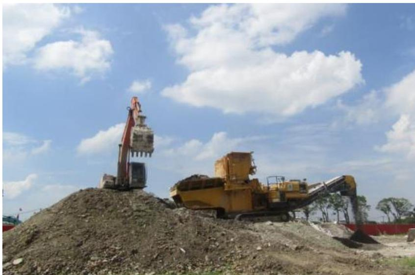
图 4-18 固化稳定化施工
